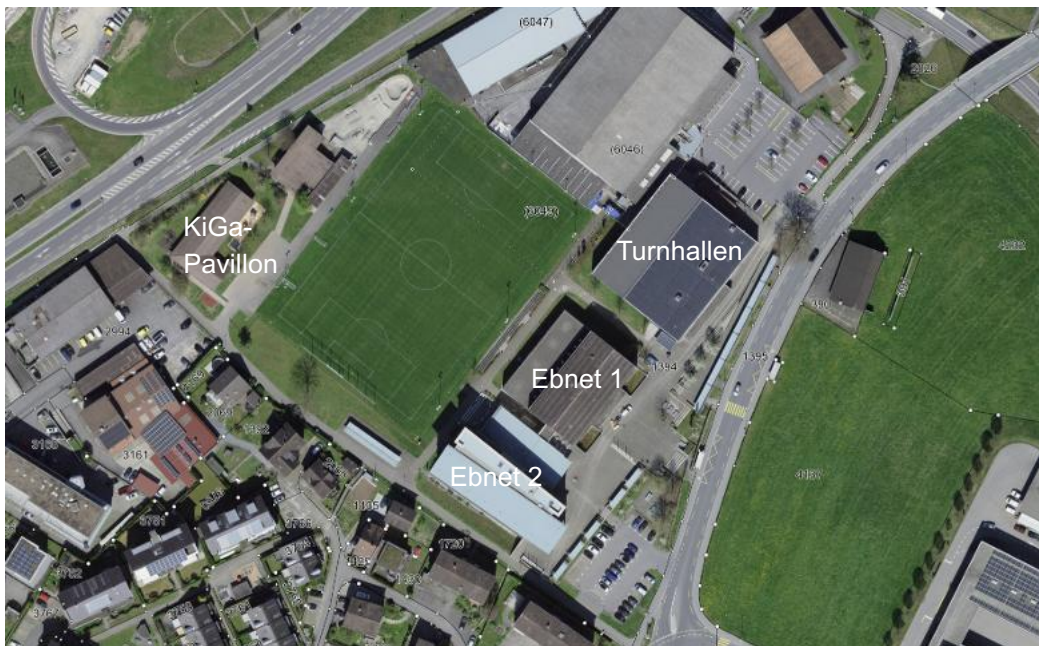
Abb. 8 Schulanlage Ebnet (WebGIS Schwyz)
