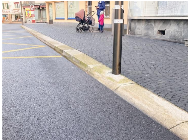
Abbildung 15: Bordstein Bushaltestelle: Kasseler Sonderbord (Naturstein) oder Natursteinbord
