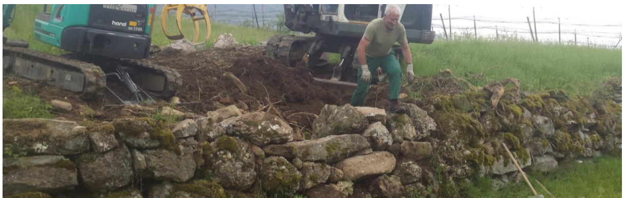
Abb. 10 Sanierung der Trockensteinmauer im Breitfeld im Jahr 2015.
