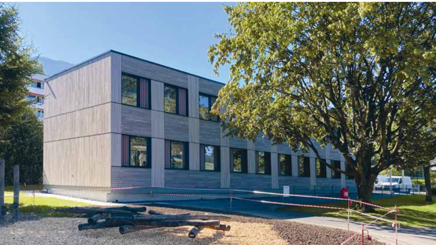
Der modulare Schulpavillon im Seematt wurde zu Beginn des neuen Schuljahres bezogen.
