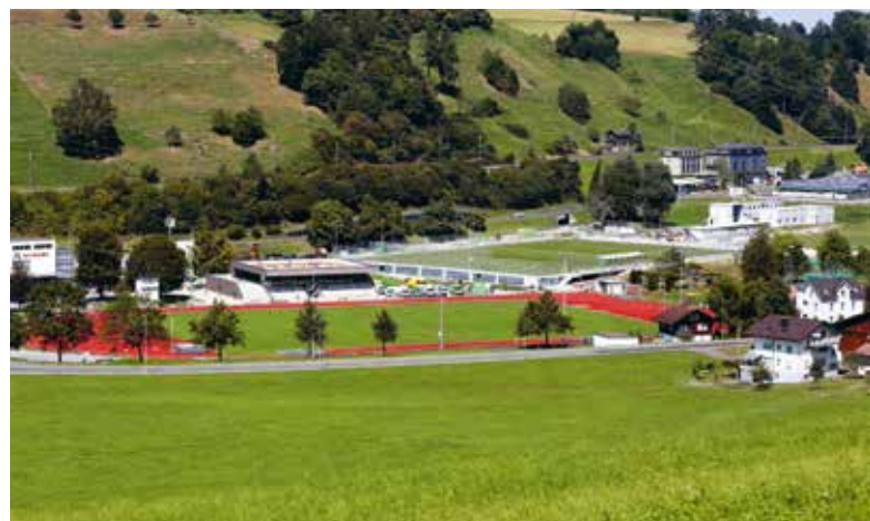
Die Sportanlage Luterbach im August 2023 kurz vor der Vollendung.
