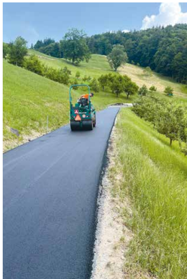
Im Frühsommer wurde der neue Deckbelag auf der Seebodenstrasse eingebracht
