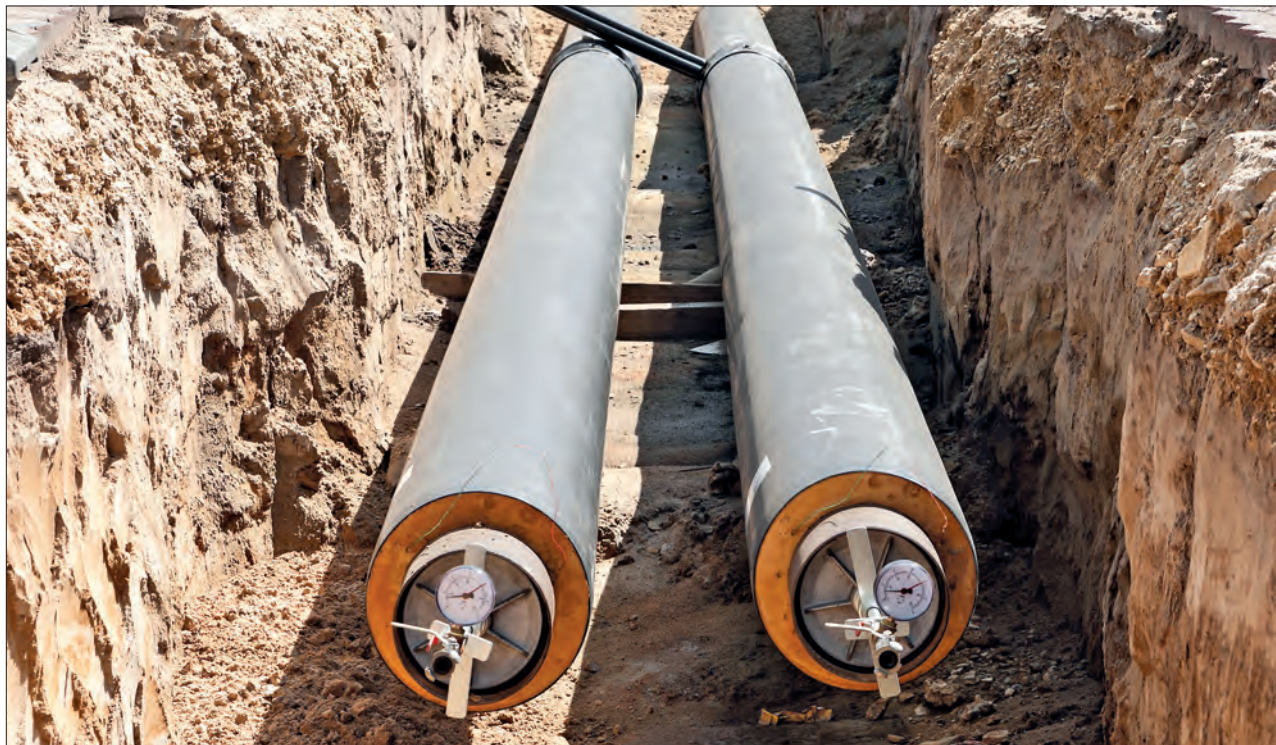
Verlegung von neuen Fernwärmerohren.
