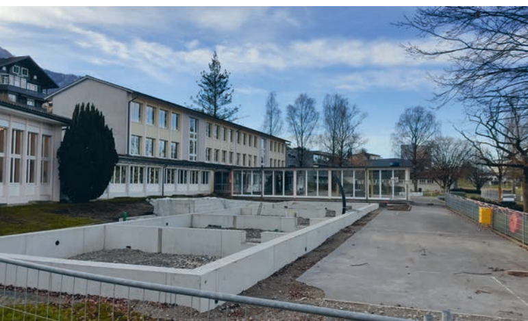
Beim Schulhaus Seematt 1 entsteht gegenwärtig modularer Schulraum.
