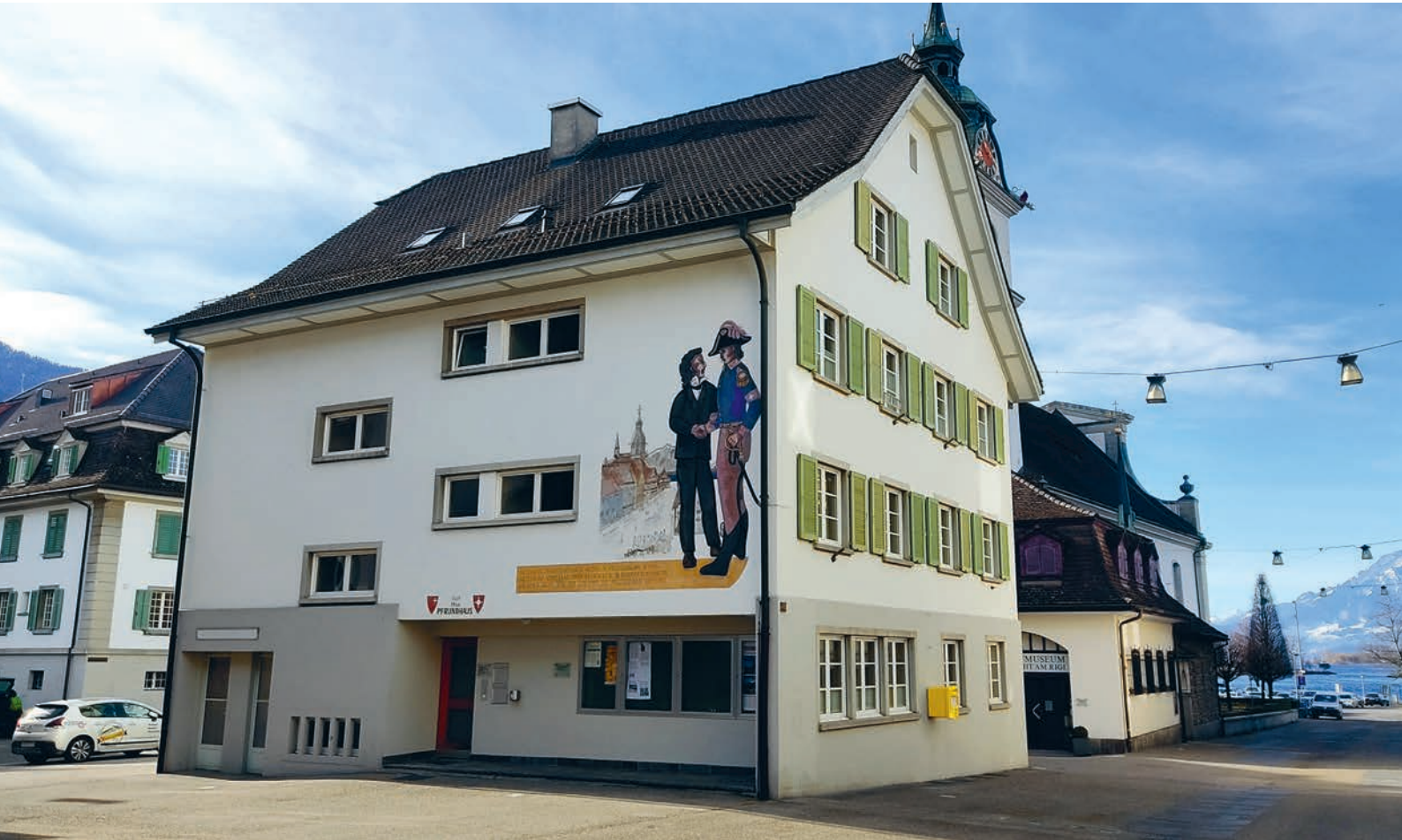
Die Abteilungen Finanzen/ICT sowie Zentrale Dienste befinden sich im Pfrundhaus.
