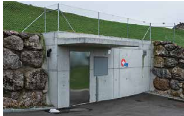
Reservoir Chiemen mit einer Löschwasserkapazität von 700 Kubikmeter
